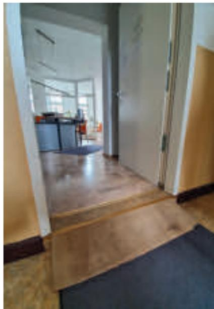
Der Eingang zur Praxis von Dr. Nicole Primas, einer umgebauten Altbauwohnung, hat eine Stufe – die selbstgebaute Rampe (rechts) ist aus Sicht des Sachverständigen jedoch zu kurz und zu steil, außerdem liegt sie zu nah an der Treppe.
