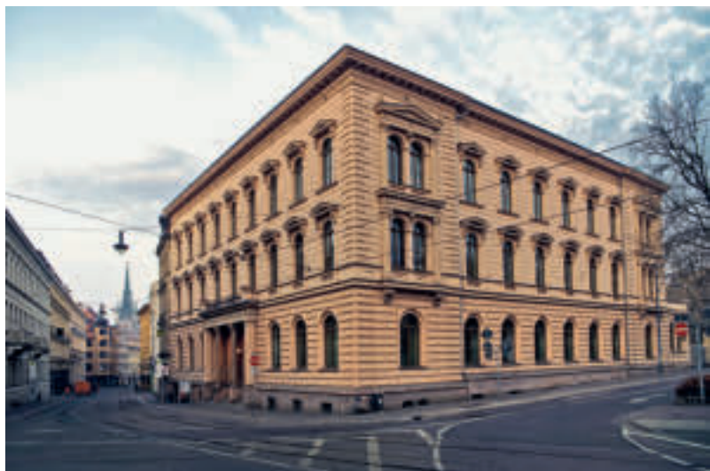
In dem 1867 als Bank erbauten Gebäude in der Großen Steinstraße 19 in Halle (Saale) war von 1936 bis 2017 die Zahnklinik untergebracht. Generationen von Patienten wurden hier versorgt, Generationen von Zahnmedizinern ausgebildet. Das Objekt ist wieder eine Liegenschaft des Landes. Foto: Universitätsmedizin Halle
