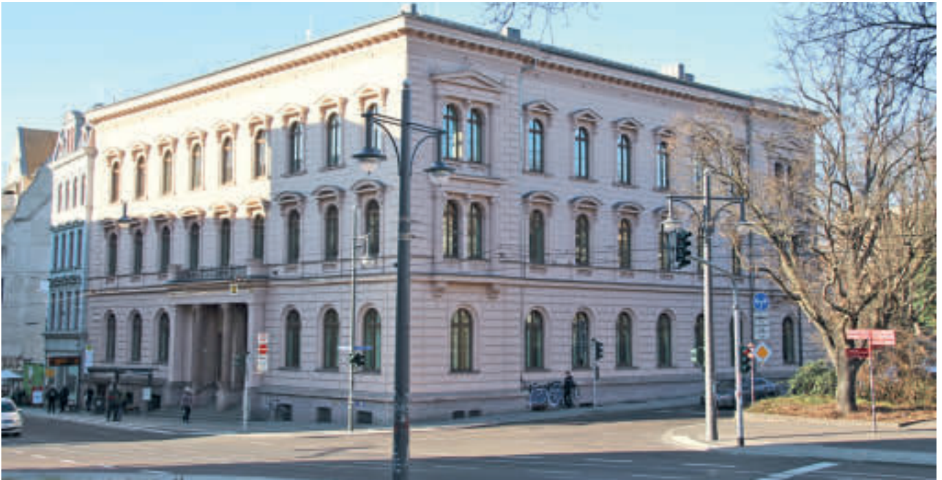
Abb. 1: Ansicht der ehemaligen Uni-Zahnklinik von der gegenüberliegenden Hauptpost. Die Morgensonne leuchtet auf den ehemaligen Räumen der Zahntechnik in der II. Etage. In der I. Etage darunter befanden sich die ehemaligen OP-Räume und die Bibliothek. Die Räume in der Gebäudeecke der I. Etage waren die Direktorenzimmer. Fotos: privat
